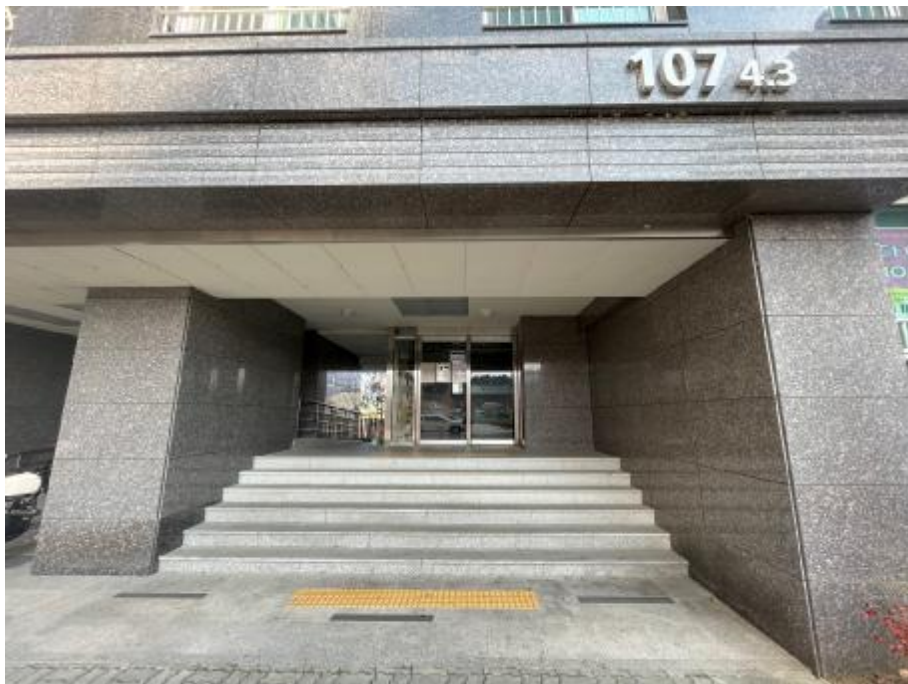
일련번호(14) ~ (16) 공동 출입문
