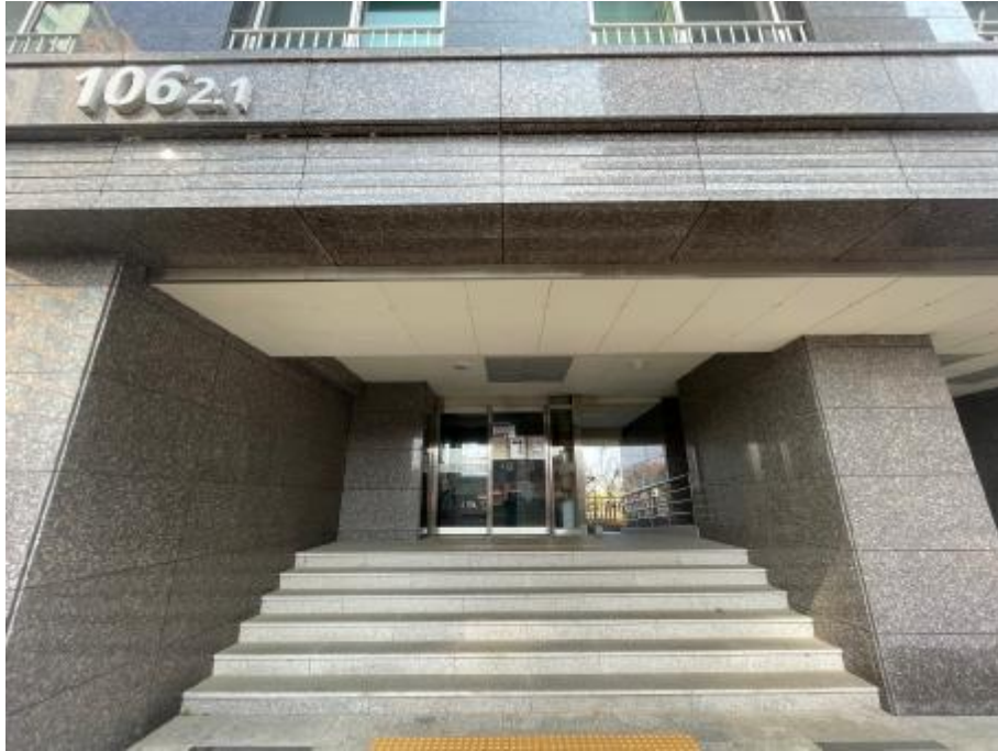
일련번호(6), (7), (9), (11) 공동 출입문
