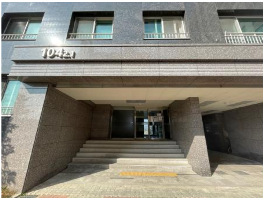
일련번호(3) 공동 출입문
