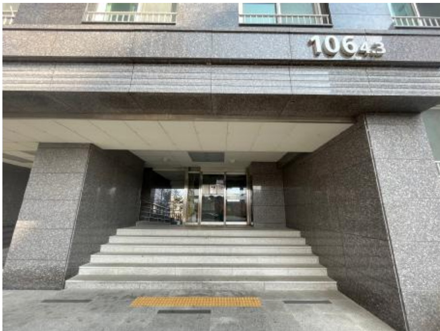
일련번호(8), (10), (12) 공동 출입문
