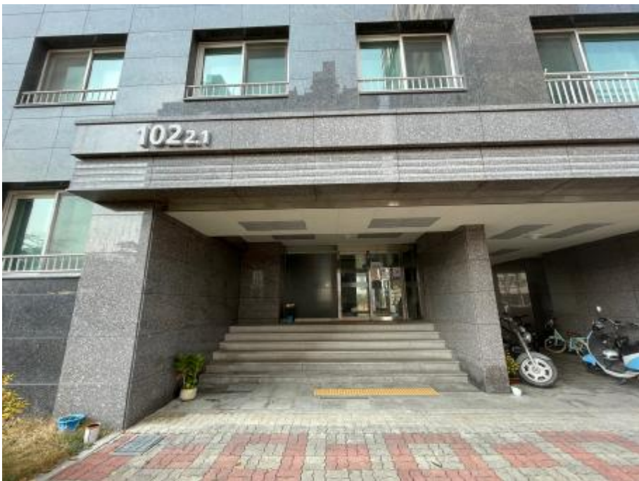
일련번호(1), (2) 공동 출입문
