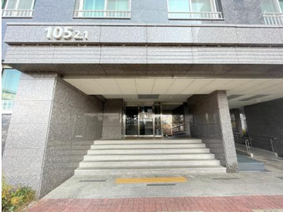
일련번호(5) 공동 출입문
