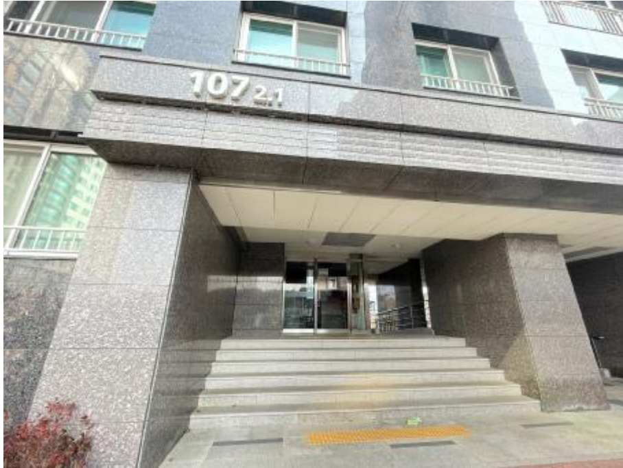
일련번호(13) 공동 출입문
