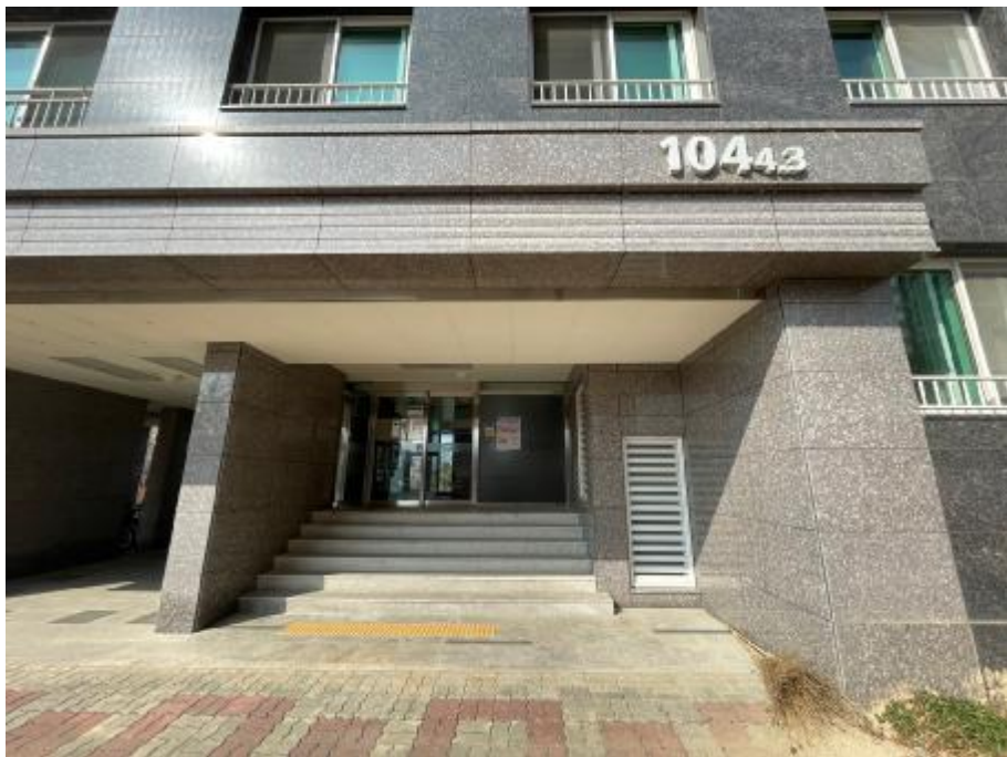
일련번호(4) 공동 출입문
